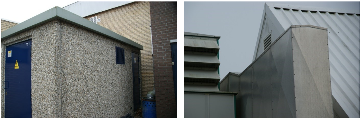
Figuur 3: links te verwijderen trafohuisje met dakrand en ventilatierooster en rechts dakdetail nok van opbouw binnenbad. De donkere ruimten zijn zeer klein en niet volledig duister. Het materiaal biedt weinig grip voor vleermuizen om zich vast te houden.
