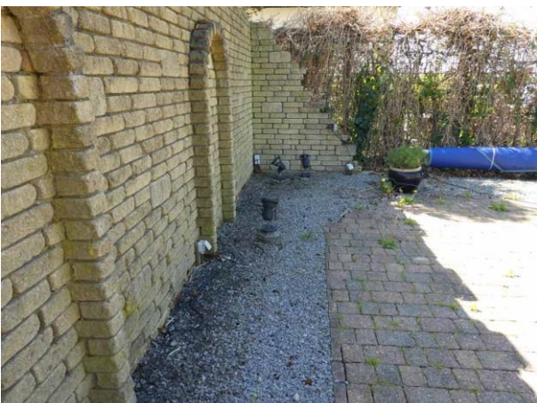
Figuur 17 Tuin- en gevelverlichting ten zuiden van het huis
