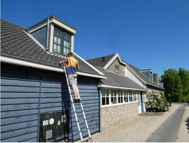
Figuur 13 Onderzoek naar ruimte onder de dakpannen
