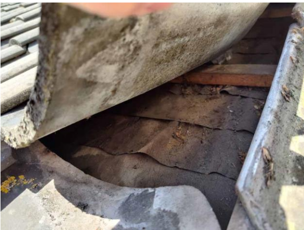
Figuur 21 Ruimte onder de dakpannen van het woonhuis
