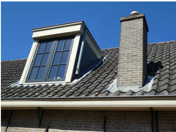
Figuur 11 Dakpannen die strak op het dak van het woonhuis liggen
