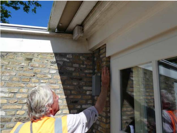
Figuur 15 Ruimte tussen de gevel te nauw voor vleermuizen, minder dan halve pink dikte
