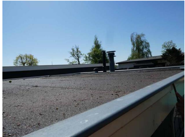
Figuur 20 Het platte dak van de schuur
