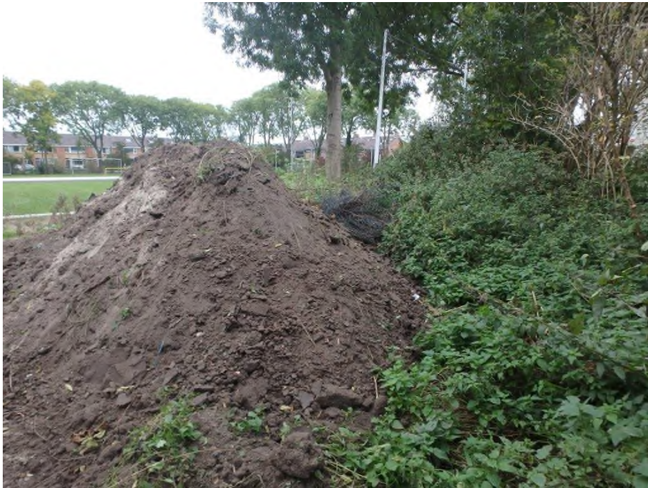
Foto 3: Partij opgebracht grond ter hoogte van de toekomstige uitrit
