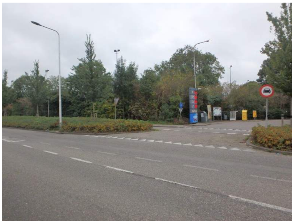
Foto 8: Overzicht vanaf de Goudseweg met zicht op uitrit tankstation en toekomstige uitrit brandweerkazerne
