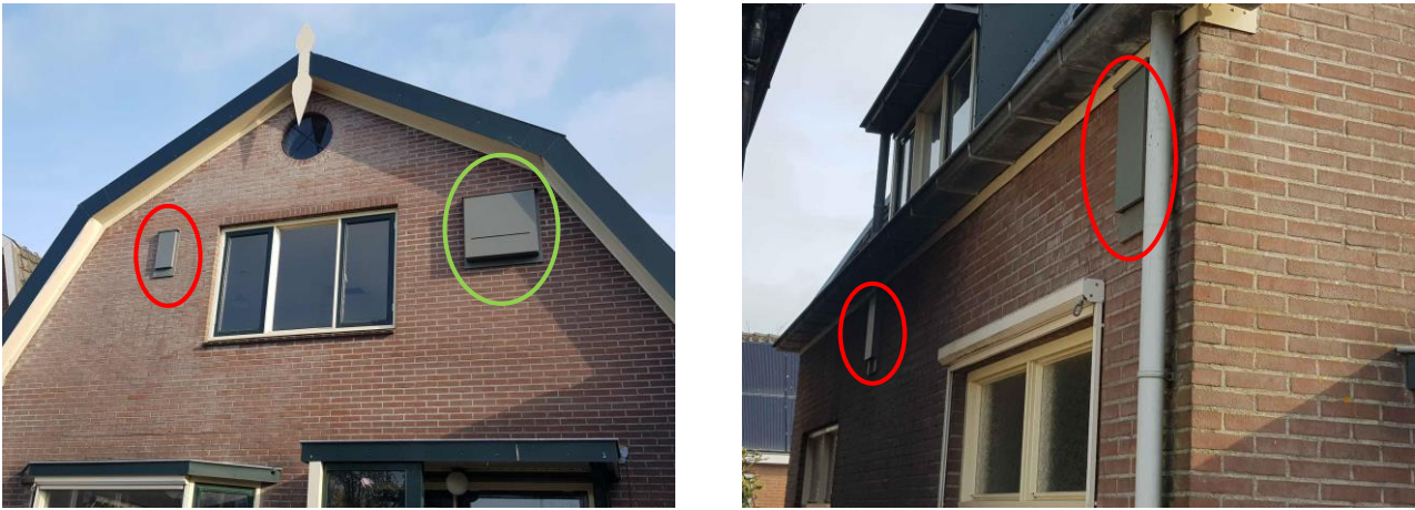
Figuur 15: Tijdelijke zomer/paarverblijven aan de zuidgevel (foto links) en in poort aan de westgevel (foto rechts)
