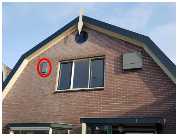
Figuur 7: Tijdelijke vleermuiskast in gebruik door Gewone dwergvleermuis (rode contour)
