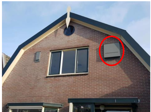
Figuur 12: Tijdelijke vleermuiskast in gebruik door Gewone dwergvleermuis (rode contour)
