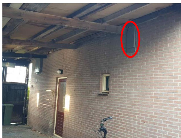
Figuur 10: Tijdelijke vleermuiskast in gebruik door Gewone dwergvleermuis (rode contour)
