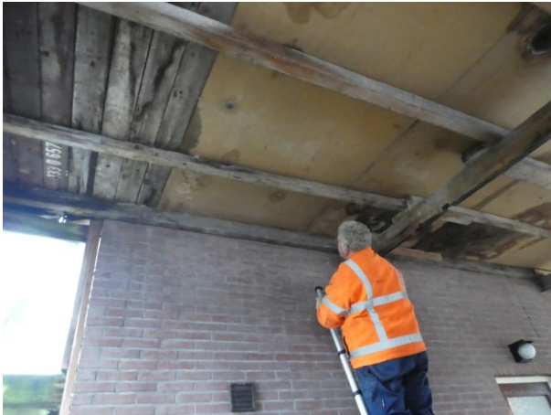
Figuur 18 Bouwkundige inspectie carport
