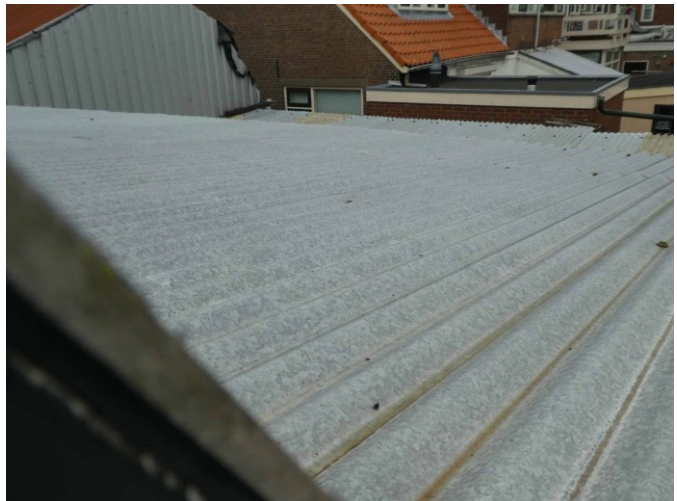
Figuur 9 Dak schuur met ijzeren golfplaten
