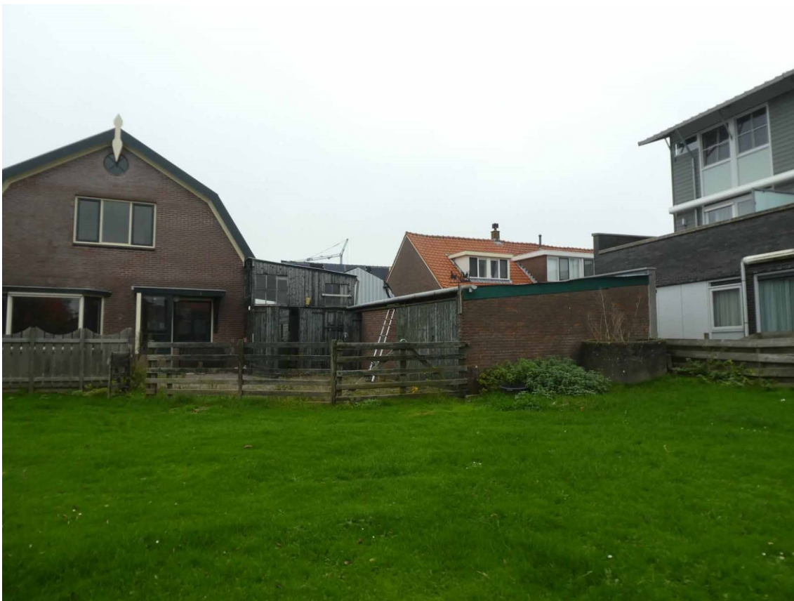
Figuur 4 Achterzijde plangebied, links te handhaven woonhuis, rechts af te breken schuren
