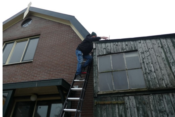
Figuur 16 Bouwkundige inspectie carport dak
