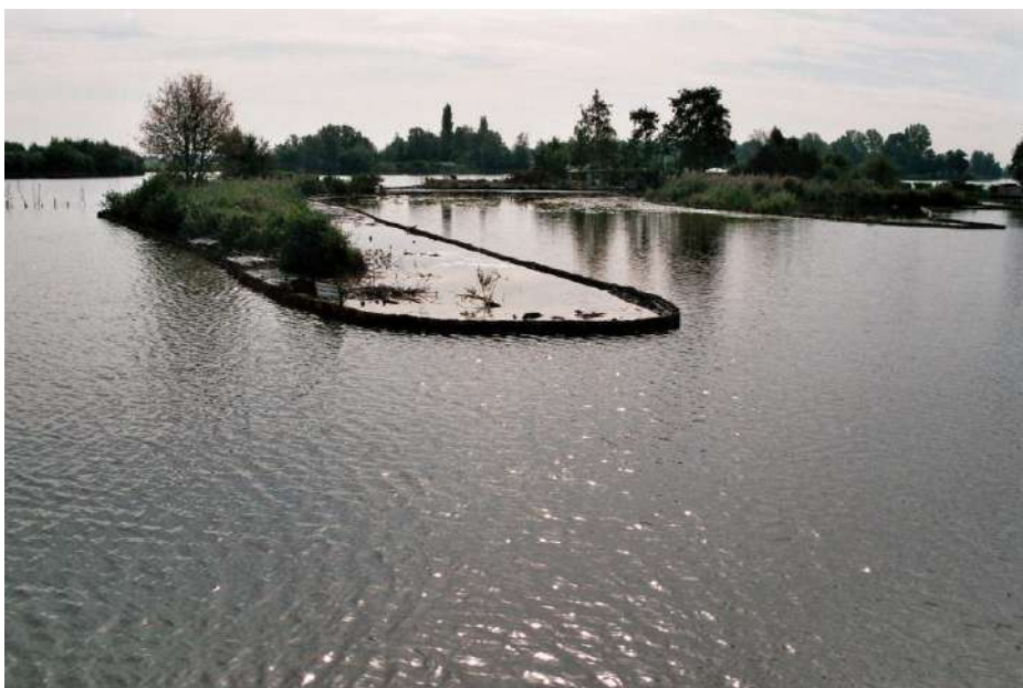
Afbeelding 46: plaszijde constructie type A (de getoonde oever is in aanleg)
