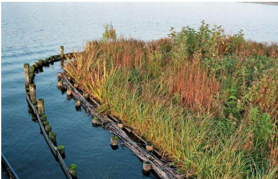
Afbeelding 45: plaszijde constructie type A
