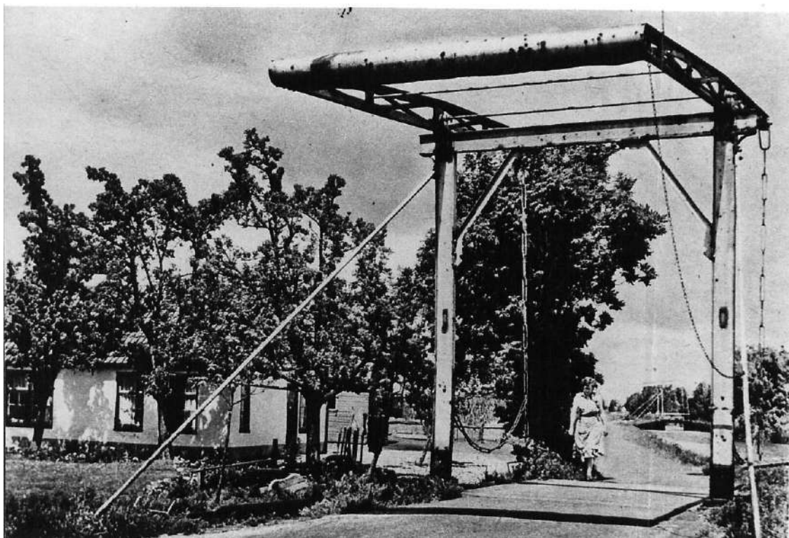
Afbeelding 57: Vieressenbrug, inmiddels vervangen door een dam.
