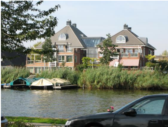
Kleinschalig appartementencomplex aan de Zoutmansweg tegenover de planlocatie.
