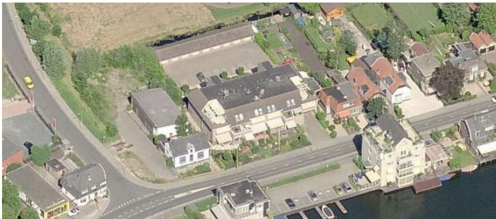
Afbeelding 17: oude verhardingssituatie bedrijfsterein Zoutmansweg 68 70
