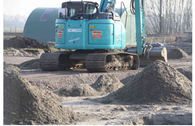
Fotonummer: 8. Werkzaamheden in uitvoering
