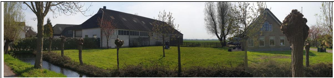
Afbeelding 4: Doorzicht tussen Westeinde 69 en 73.
