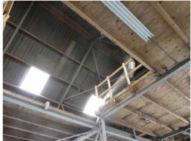
Figuur 11: De zolder en dak van het westelijke gedeelte van Westeinde 69
