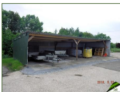
Fig. 7b. Kapschuur met verharding
