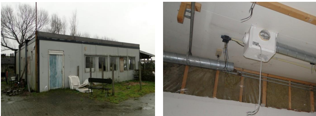
Figuur 8: Links: exterieur woonunit. Rechts: interieur, deel plafond met isolatielaag.
