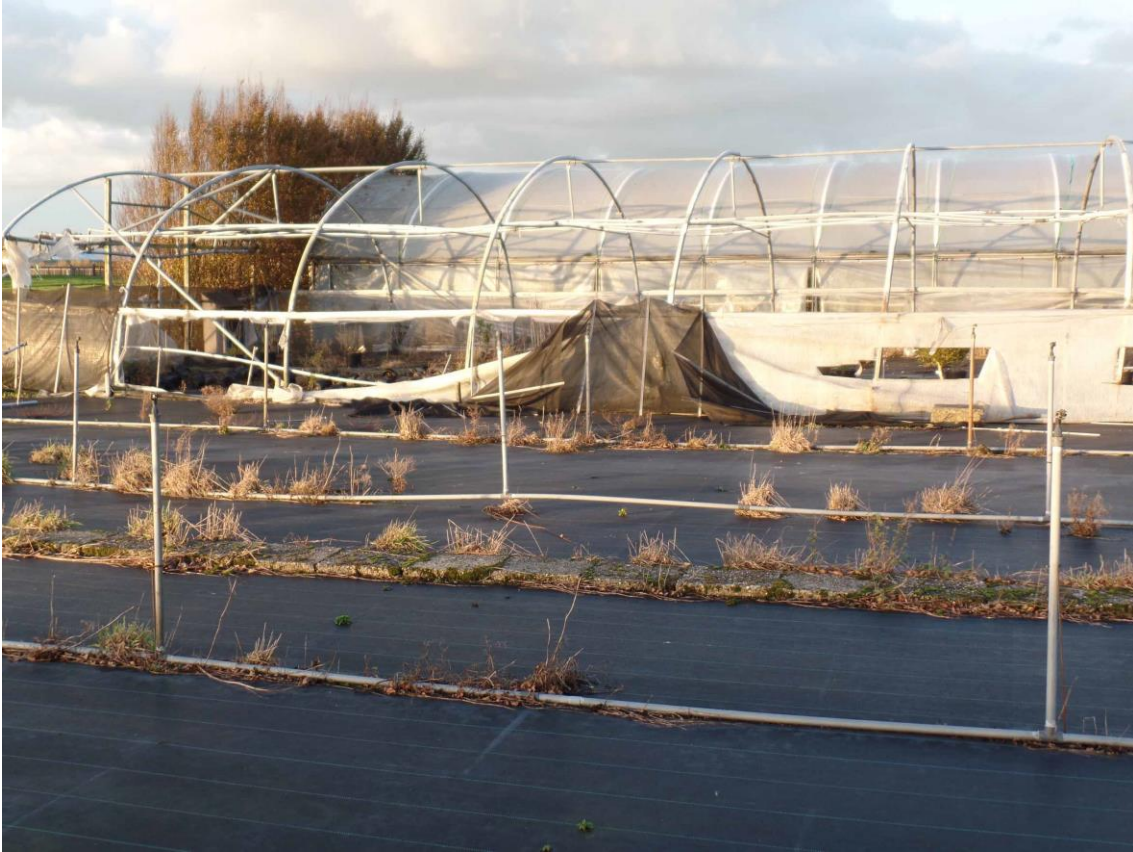
Figuur 5: Van een deel van de tunnelkassen staat alleen nog het skelet
