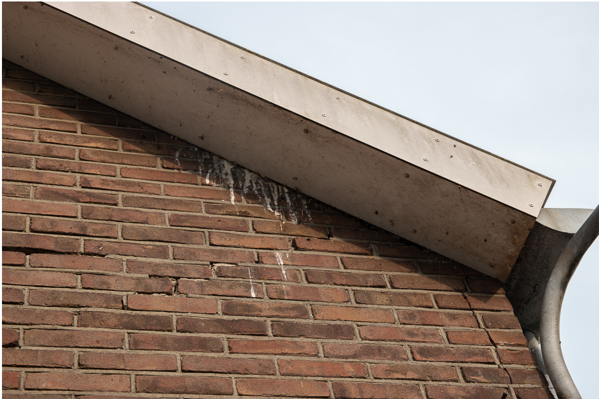
Westgevel loods met vogelschijfstrepen op de gevel onder het nest van een spreek achter de boeiborden.
