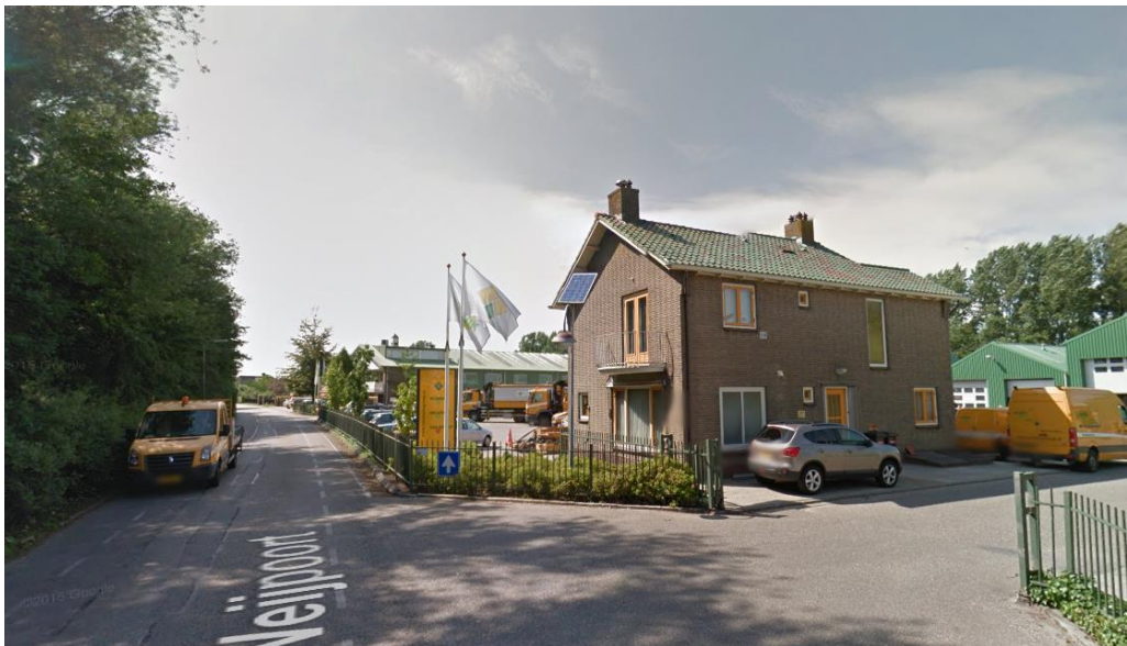
3.) Aannemersbedrijf (Bron: Google Streetview)
