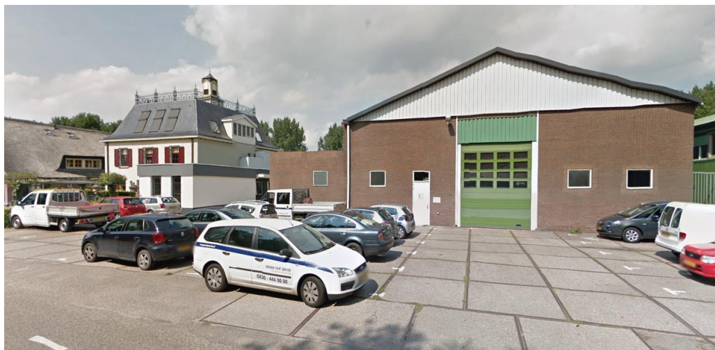
1.) Woning met bijbehorende bedrijfshal aan de Weijpoort 21 (Bron: Google Streetview)
