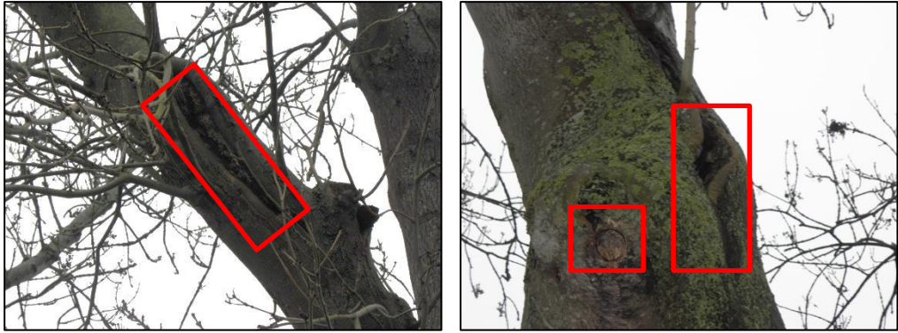
Impressie van de in het plangebied aangetroffen openingen (rood omkaderd) die als verblijfplaats voor boombewonende vleermuizen geschikt kunnen zijn.
