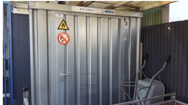
Figuur 25: Opslag oliën, oude accu's en overige gevaarlijke stoffen. Achterzijde locatie Autoschade Hogenboom
