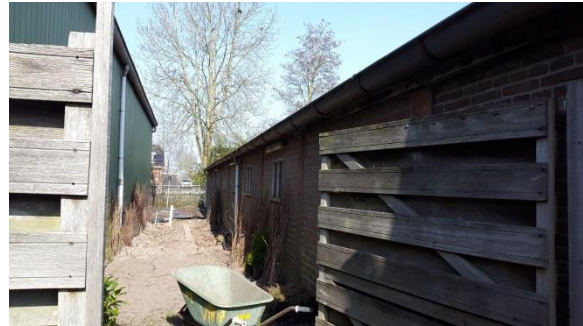
Figuur 13: Dak(goot) bebouwing
