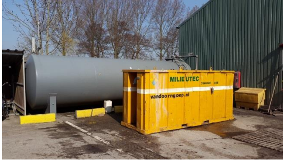
Figuur 14: Wasplaats en bovengrondse dieseloiletank (20.000 l.) (voorheen een bovengrondse rode dieseltank, 10.000 liter)
