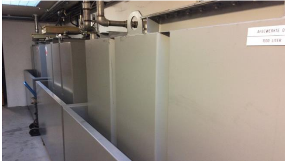
Figuur 16: Opslag motor-, hydrauliek- en afgewerkte olie
