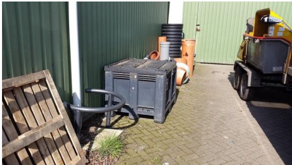
Figuur 18: Opslag accu's
