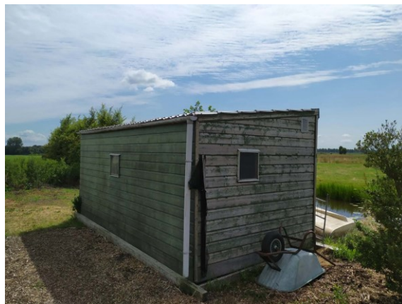
Figuur 8 Oude schuur achter op het perceel
