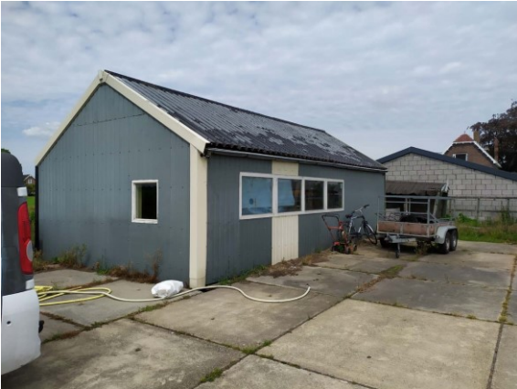
Figuur 158 Schuur opgebouwd uit damwandplaten
