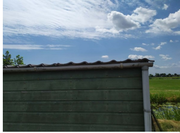
Figuur 98 Aansluiting dakpannen van opberghok
