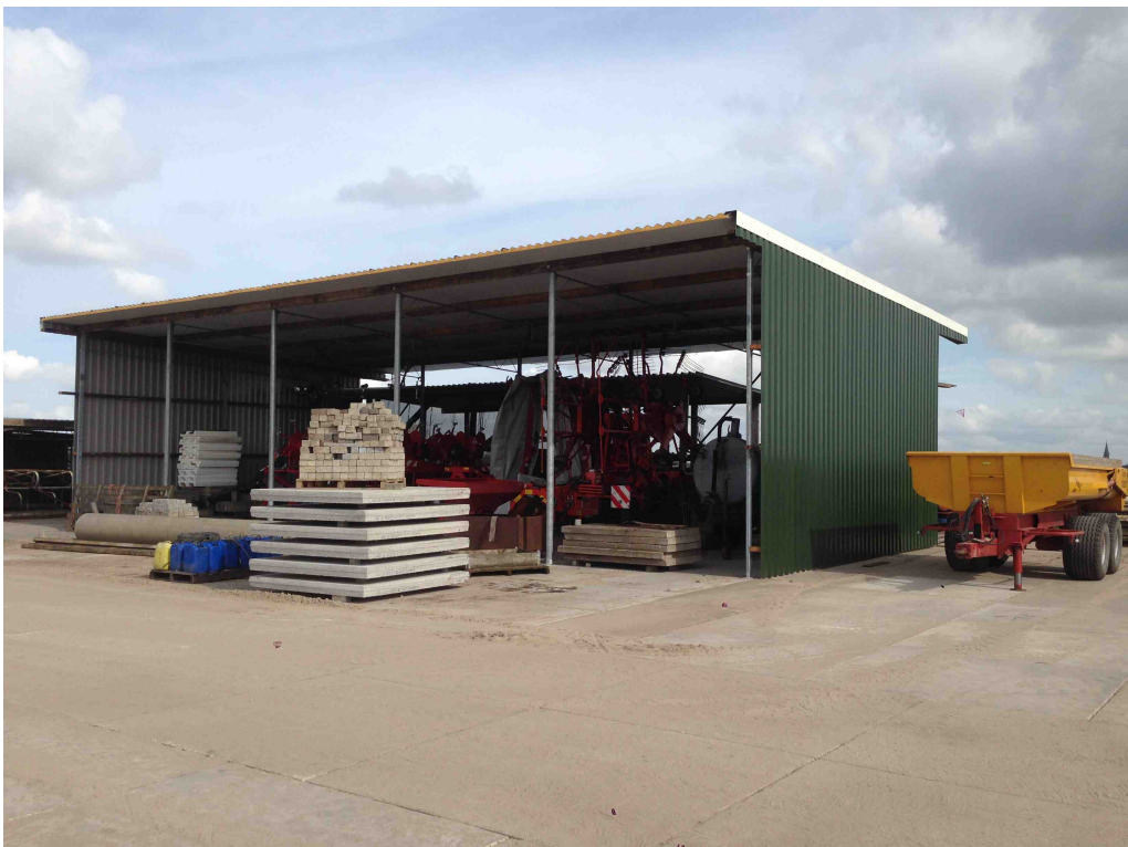
Figuur 2 De machineloods en een provisorische koeienstal worden gesloopt ten behoeve van de nieuwe stallen.
