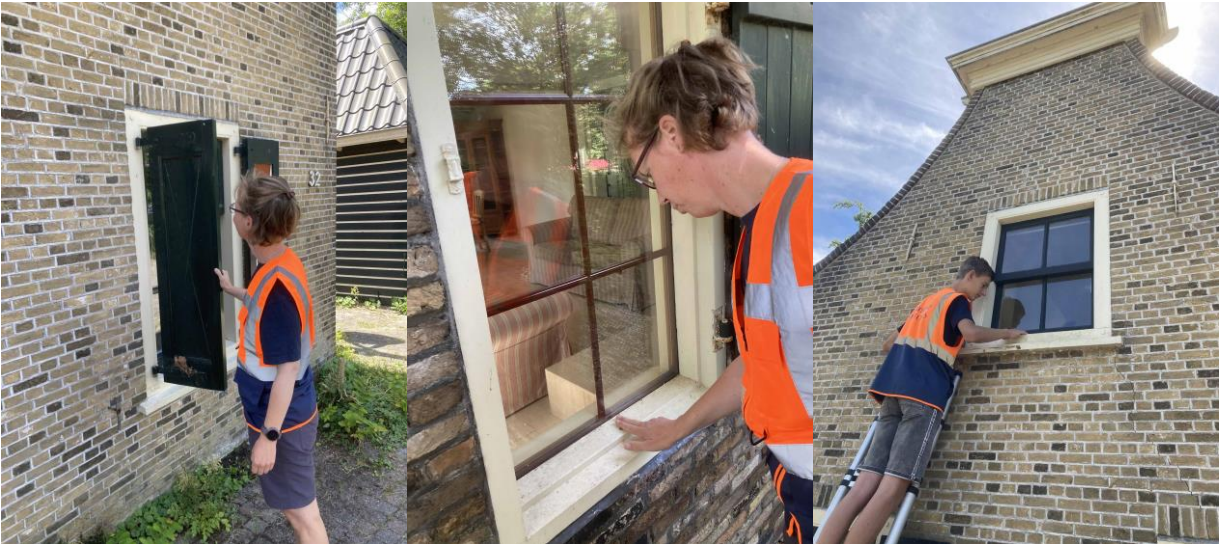
Figuur 15, 16 en 17: Nauwkeurige inspectie van de buitenkant van de woning
