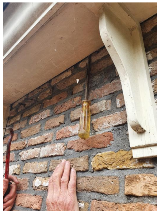
Figuur 13: Onderzijde van gevel van het huis, alles sluit naadloos aan en is in uitstekende staat van onderhoud
