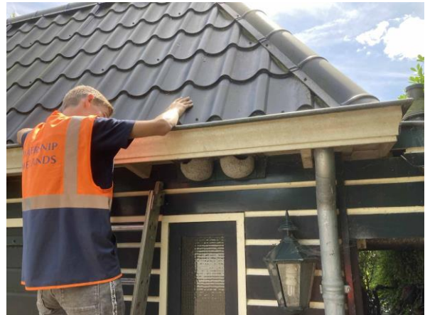
Figuur 24: Inspectie schuur
