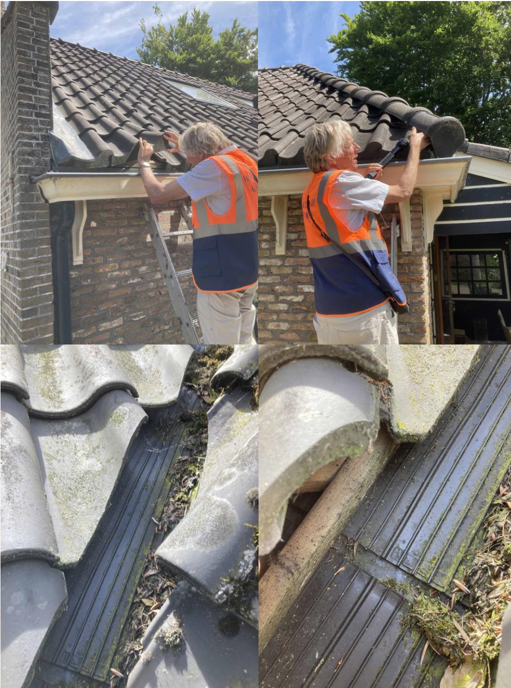
Figuur 20, 21, 22 en 23: Nauwkeurige inspectie dak
