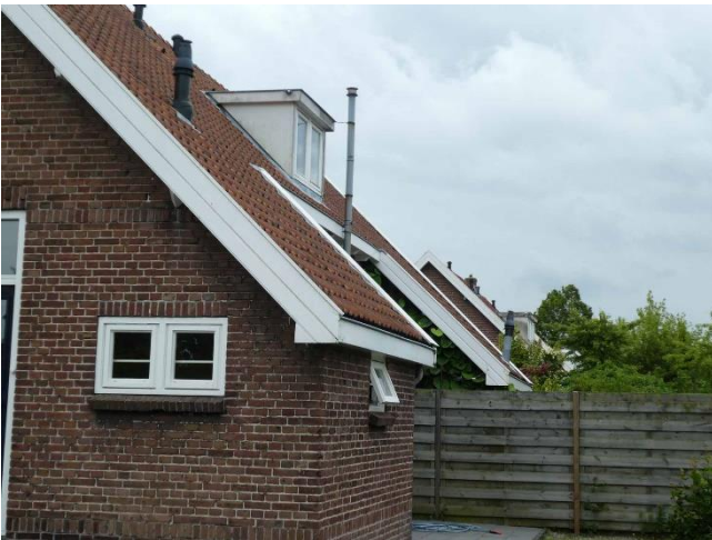
Figuur 2: Zijaanzicht van de achtergevel van één van de woningen
