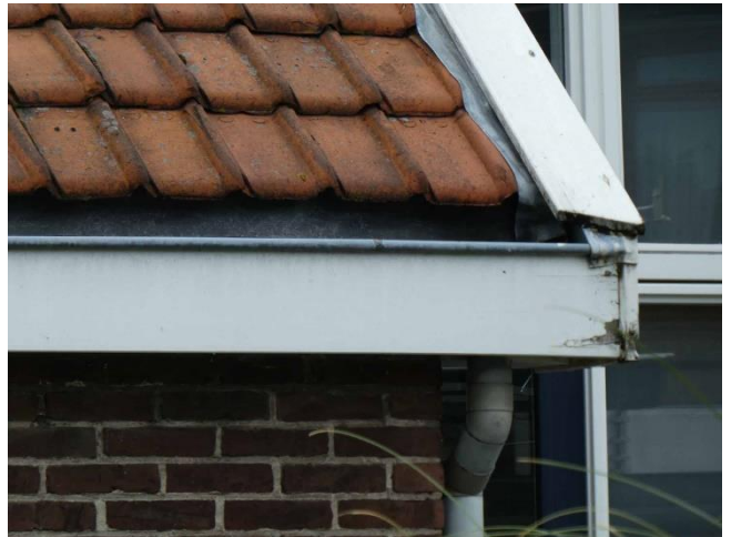
Figuur 6: Detail dakgoot met loodflap
