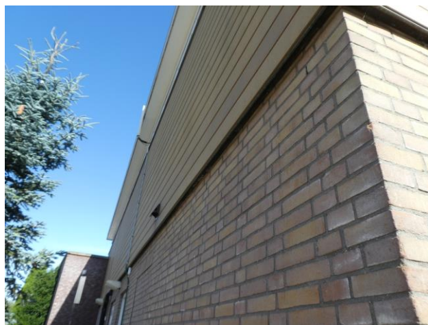
Figuur 12 Houten gevelbekleding
