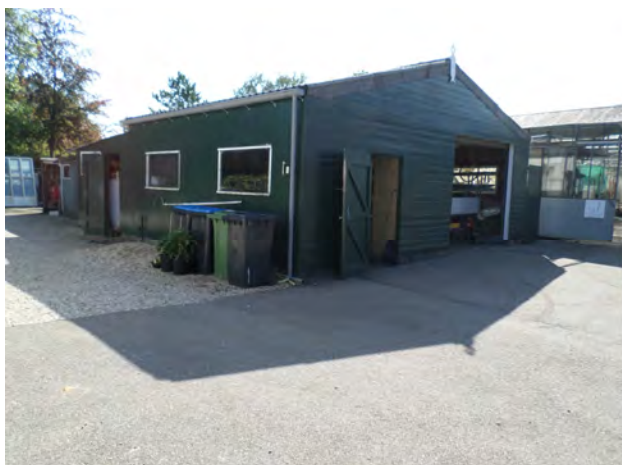
Afbeelding 3 en 4: de houtsystemebouw werkschuur met eternietgolfplaten als dakbedekking.
