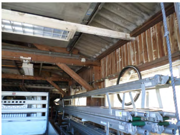
Afbeelding 3 en 4: de houtsystemebouw werkschuur met eternietgolfplaten als dakbedekking.
