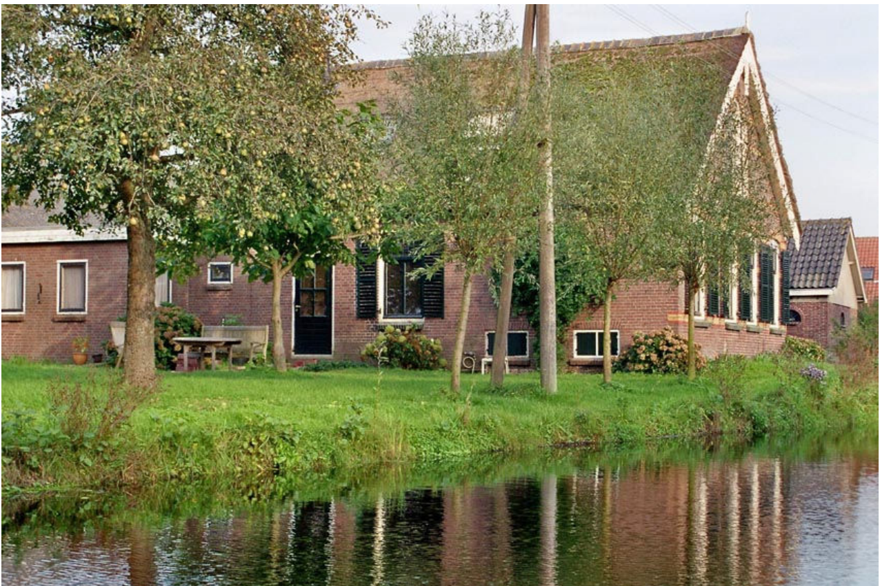
Figuur 12: Natuurvriendelijke oeverbescherming met beschoeiing direct op de waterlijn
