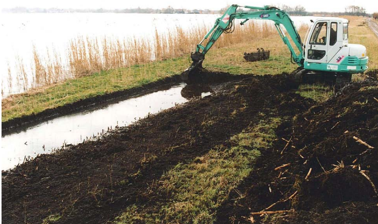
Afbeelding 37: Aanlegvergunningplichtige werken. Graven van een verlagings met oog op nieuwe rietgroei.
