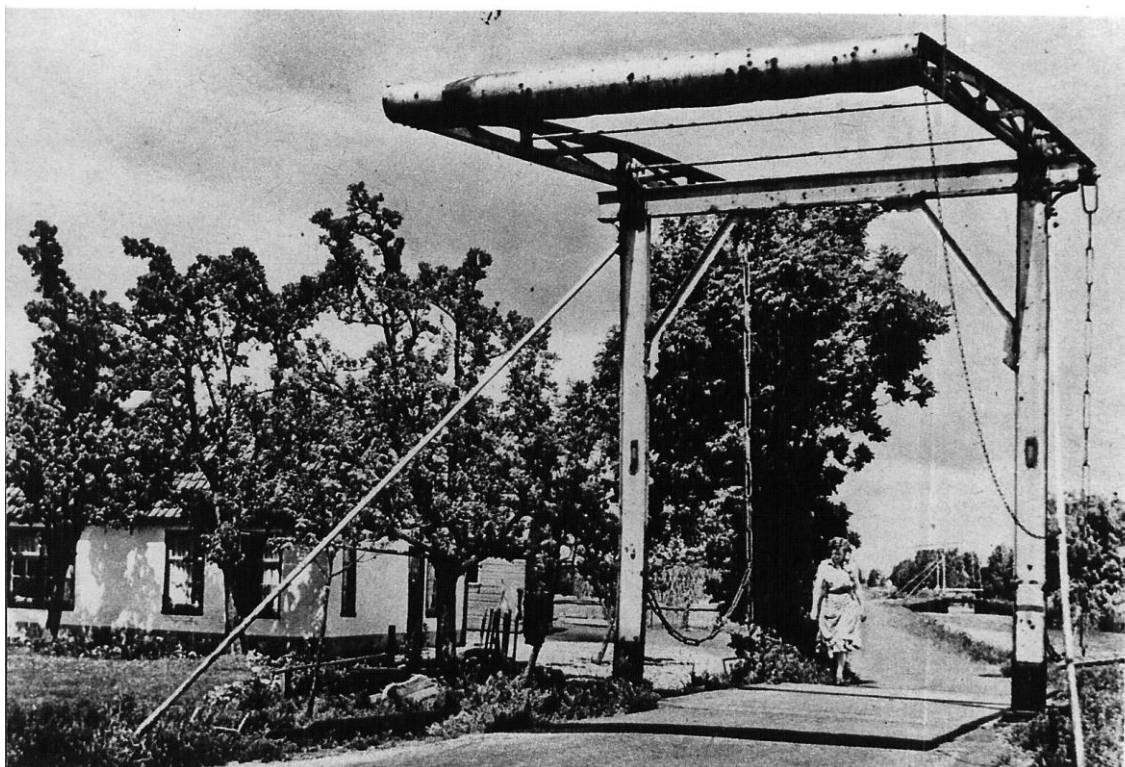
Afbeelding 57: Vieressenbrug, inmiddels vervangen door een dam.
