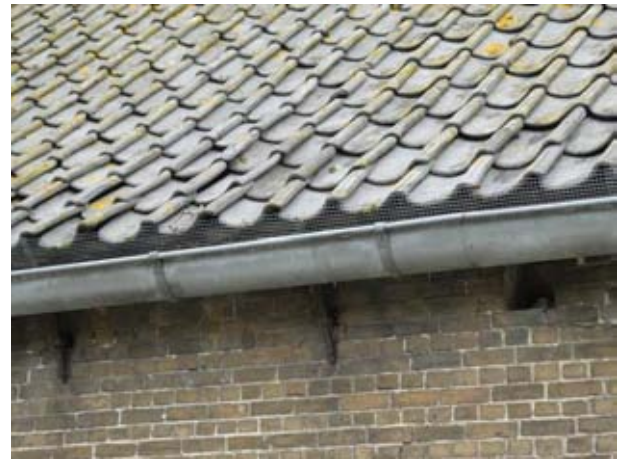
Figuur 11: Gaas in de dakgoten van de huisstal
