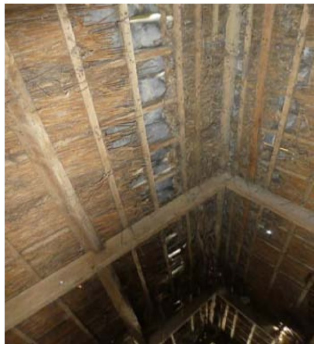
Figuur 14: Binnenzijde dak van huisstal
