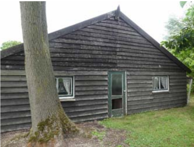
Figuur 8: Schuur b1
