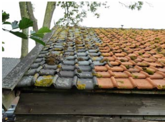
Figuur 20: Dak van schuur b1
