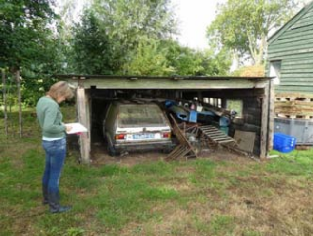
Figuur 10: Schuur b4
