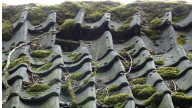
Figuur 19: Dak van schuur b9
