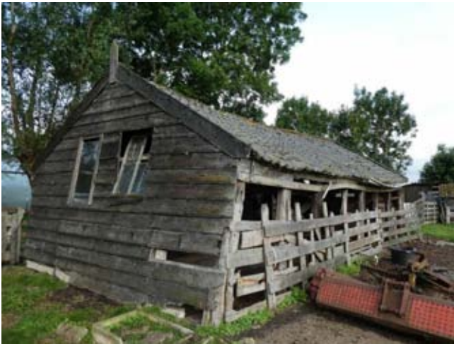
Figuur 12: Schuur b9
