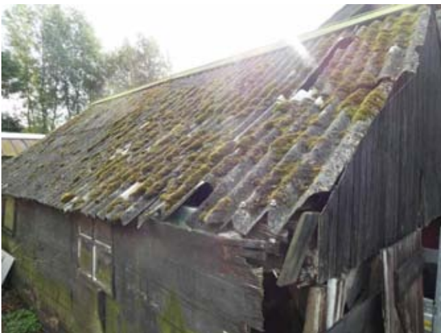
Figuur 14: Schuur b16
