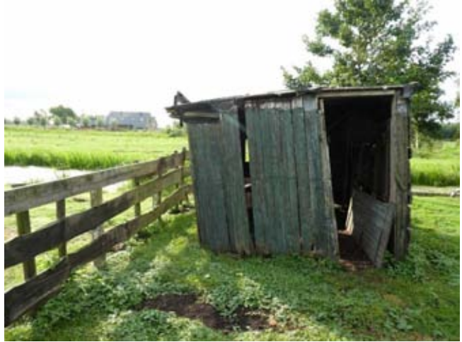
Figuur 11: Schuur b7
