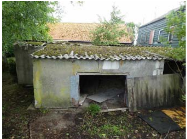
Figuur 9: Schuur b3
