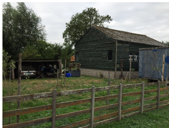
‘asbestverdacht dak’
