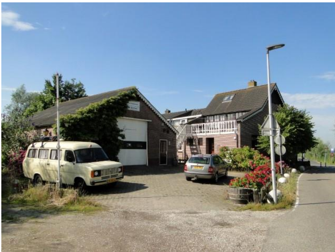
Figuur 7: gezicht vanaf de weg op de te slopen loods (links) en het woonhuis op het aangrenzende perceel (rechts).
