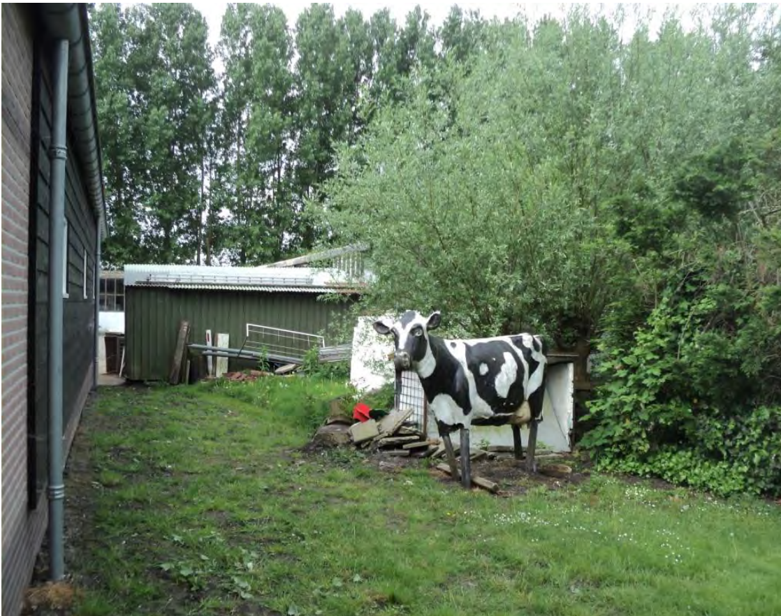
Figuur 8: Opgeslagen materialen tussen de af te breken loods en het graslandje waar de nieuwe woning komt.
