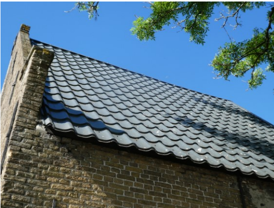
Figuur 11 Dak oude arbeiderswoning: kunststof platen imitatie-pannen
