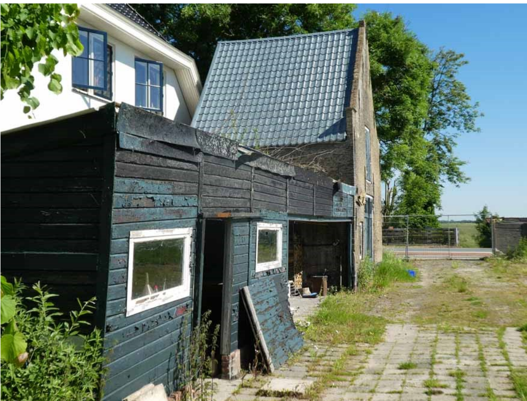
Figuur 4 Af te breken schuurtje aan arbeiderswoning, "de boenstoep"
