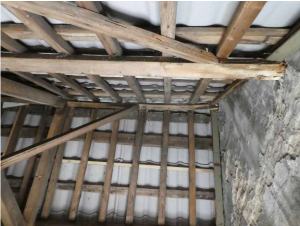
Figuur 18 Historische dakconstructie arbeiderswoning
