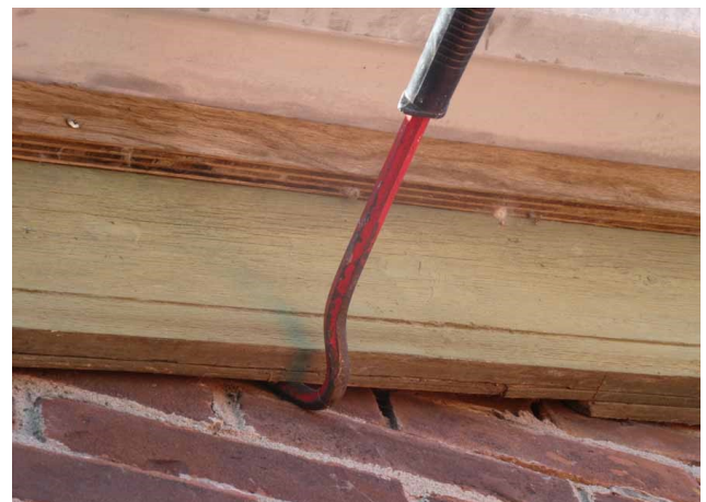
Figuur 14 Geen ruimte houten daktrim
