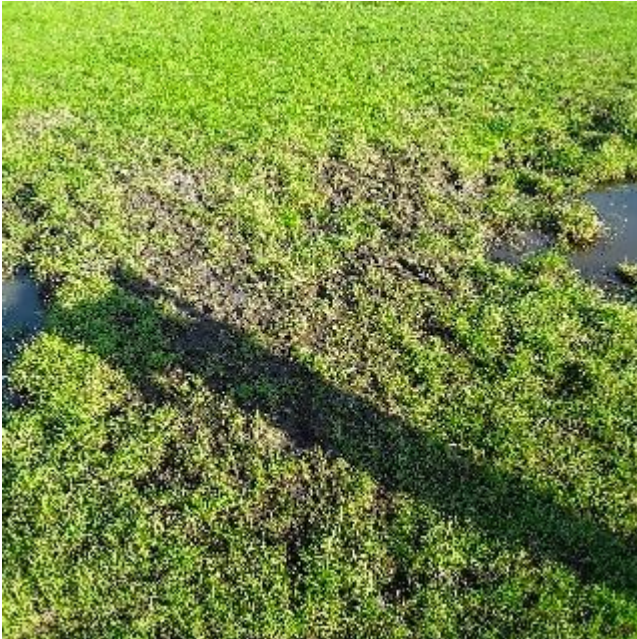
Foto's dam VD31
