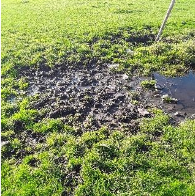
Foto's dam VD30
