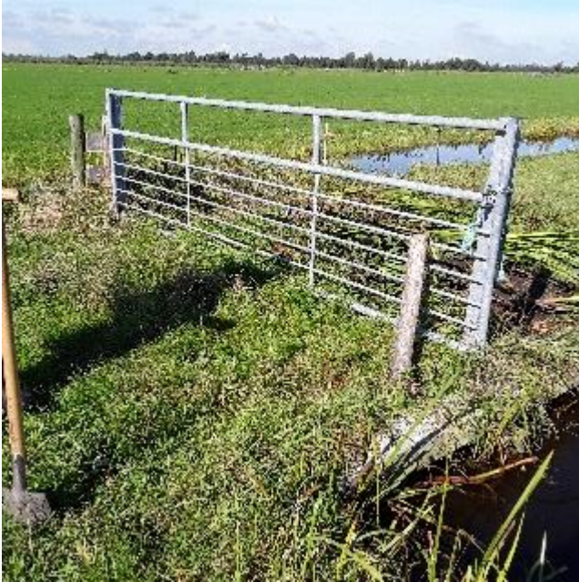
Foto's dam VD19
