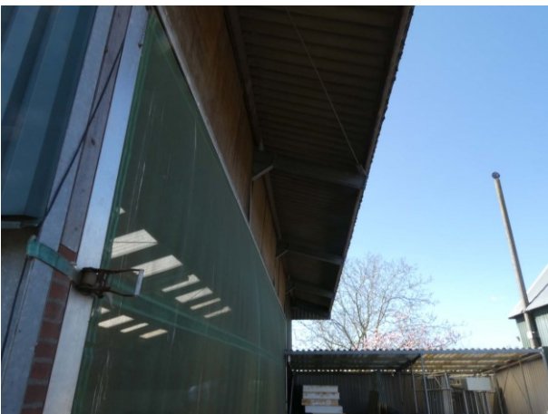
Figuur 4 Oostelijke aanzicht af te breken schuur (4)
