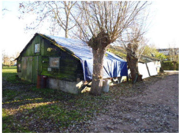
Te slopen schuur.
