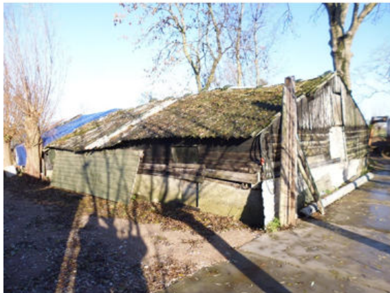
Te slopen schuur.
