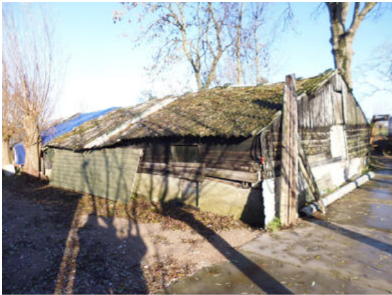
Te slopen schuur.
