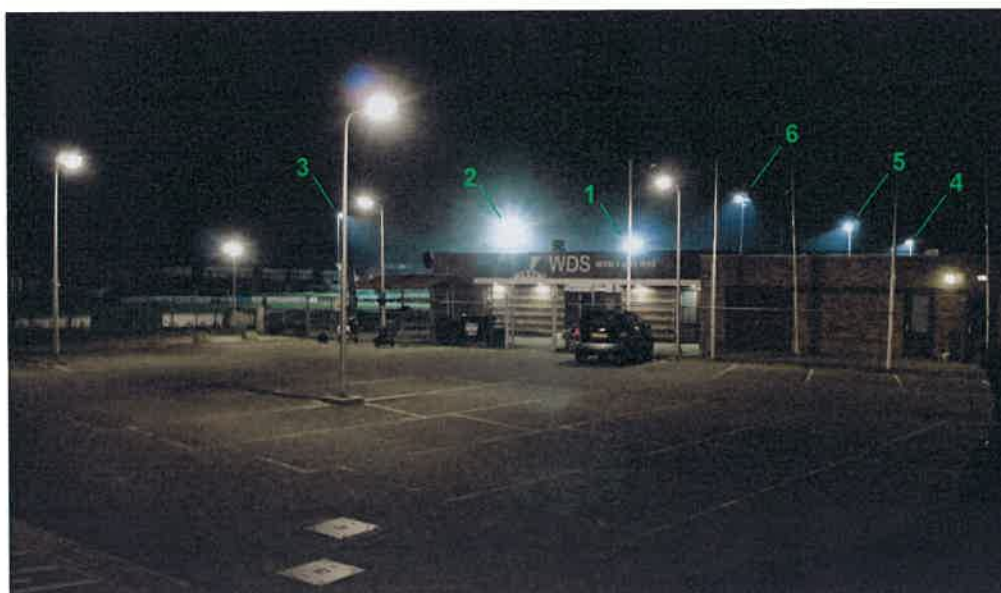
13.2 Foto lichtsituatie, inclusief nummering armaturen verlichtingsinstallatie sportpark
