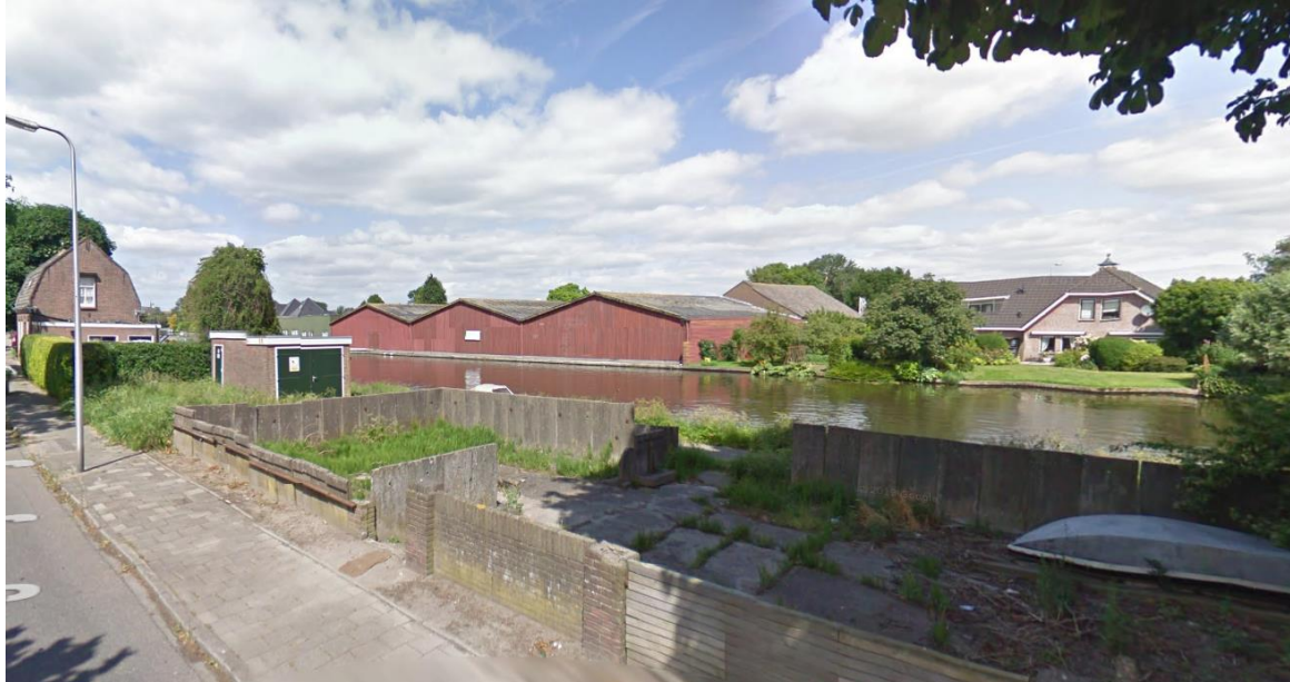
Figuur 5.1: Pprintscreen van google maps. Verharding in de funderingrestanten van de Hoge Rijndijk 34-36.
