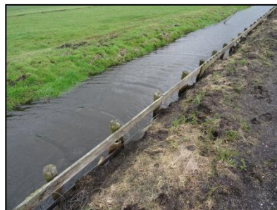
Figuur 7. Vervallen oeverbeschoeiing.
