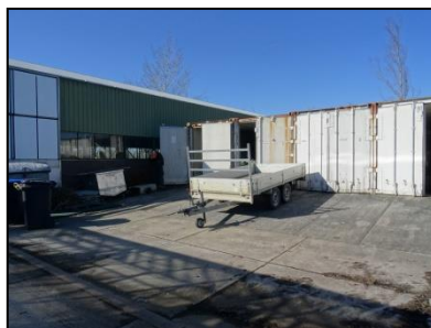
Figuur 7. Zicht op de twee garages.
