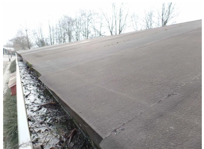
Figuur 6: Strak gelegd bitumen dak van het gebouw
