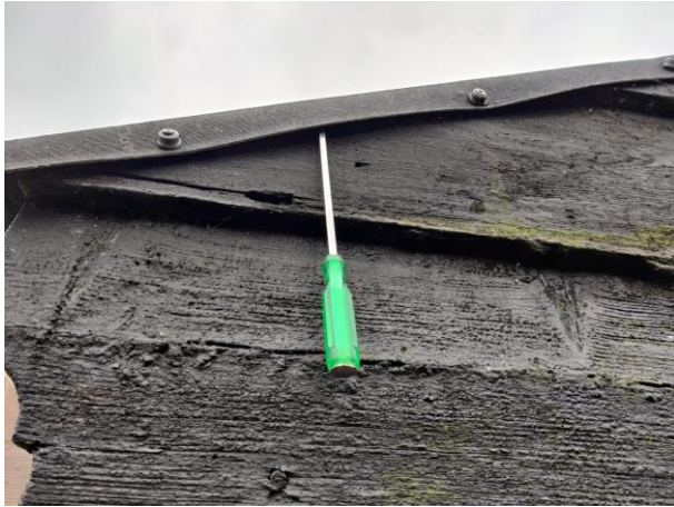
Figuur 35: Ruimte onder tussen de dakplaten en de schuur waar een schroevendraaier tussen geklemd kan worden
