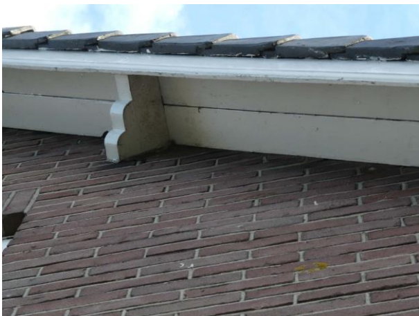
Figuur 23 t/m 26: Impressie luchtrooster, aansluiting boeiboorden en dakgoten en aansluiting dakpannen
