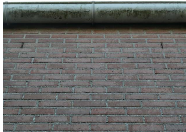
Figuur 27&28: Aangetroffen open stootvoegen westzijde garage-schuur
