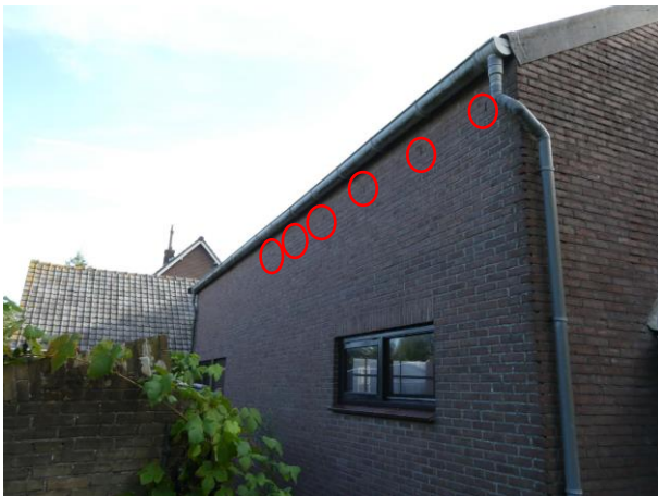
Figuur 27&28: Aangetroffen open stootvoegen westzijde garage-schuur
