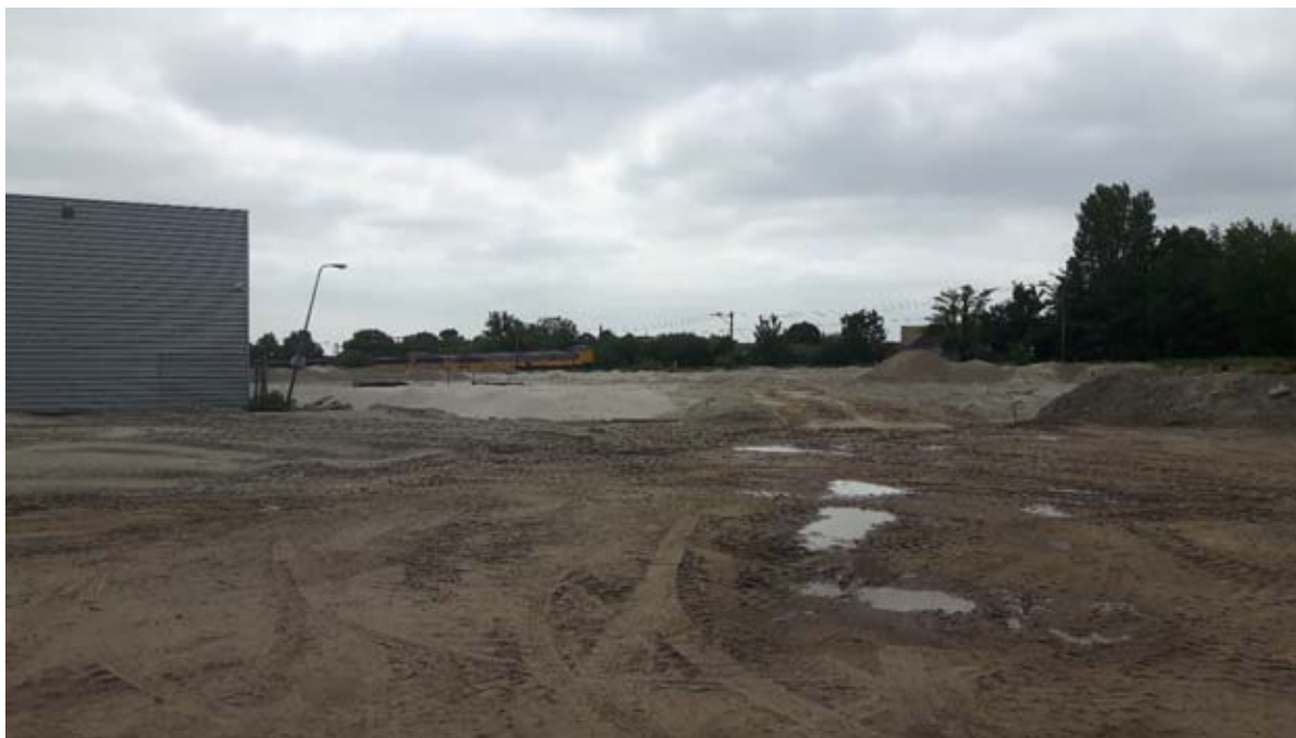
Figuur 1.1: Bouwterrein met spoorlijn op de achtergrond
