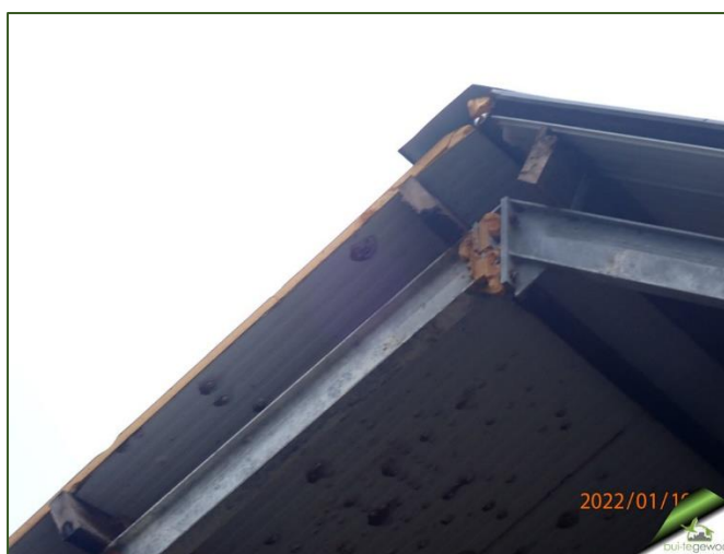
Figuur 7. Detail golfplaat constructie met isolatie
