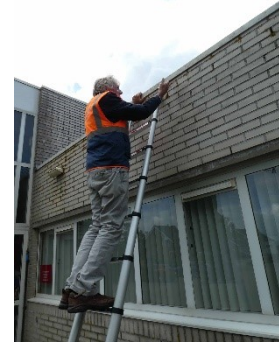
Figuur 15 Inspectie daklijst
