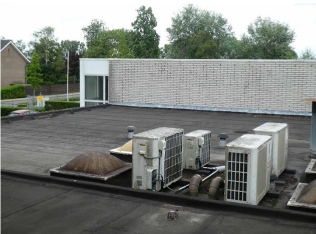
Figuur 16 Bitumen dak
