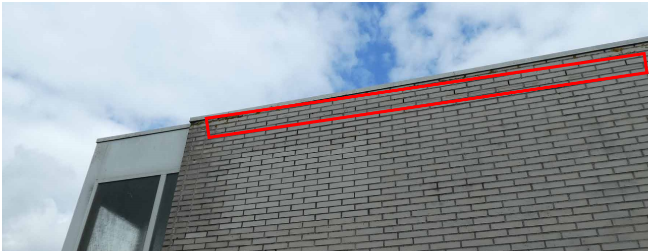
Figuur 19 Open stootvoegen
