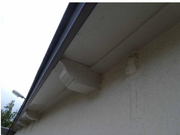
Figuur 13: Strakke aansluiting op de muren
