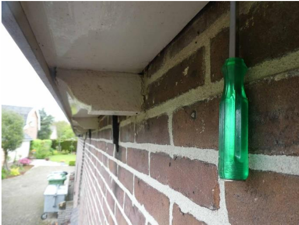
Figuur 9: Geen invliegruimte, vrijhangende schroevendraaier
