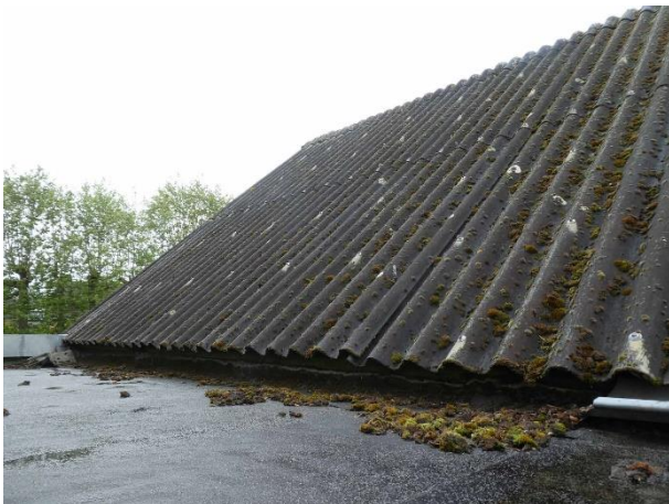
Figuur 11: Asbest golfplaten en plat dak aanbouw
