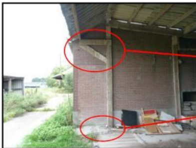
Figuur 25. Steenuilsporen in open kapschuur.
