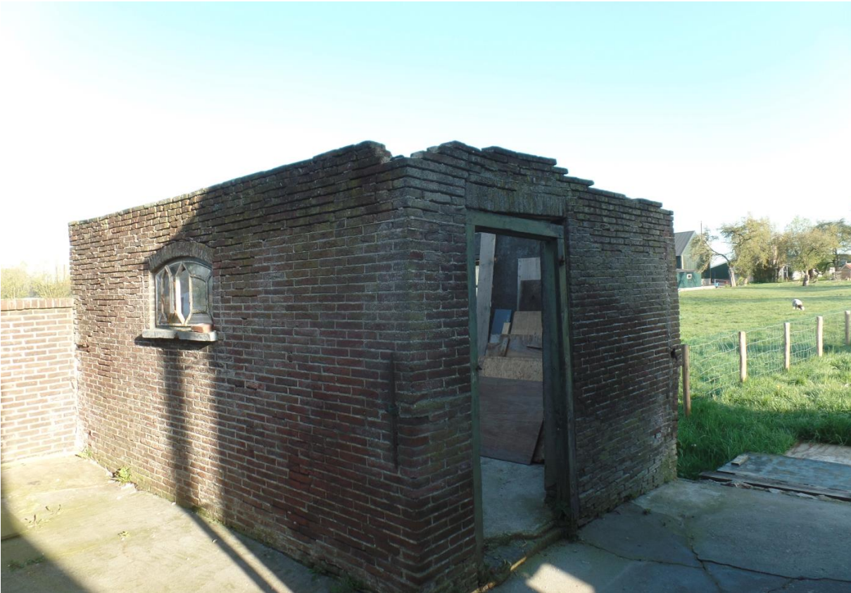
Afbeelding 7: buitenkant stenen onderbouw van de voormalige schuur waarvan het dak ontbreekt.
