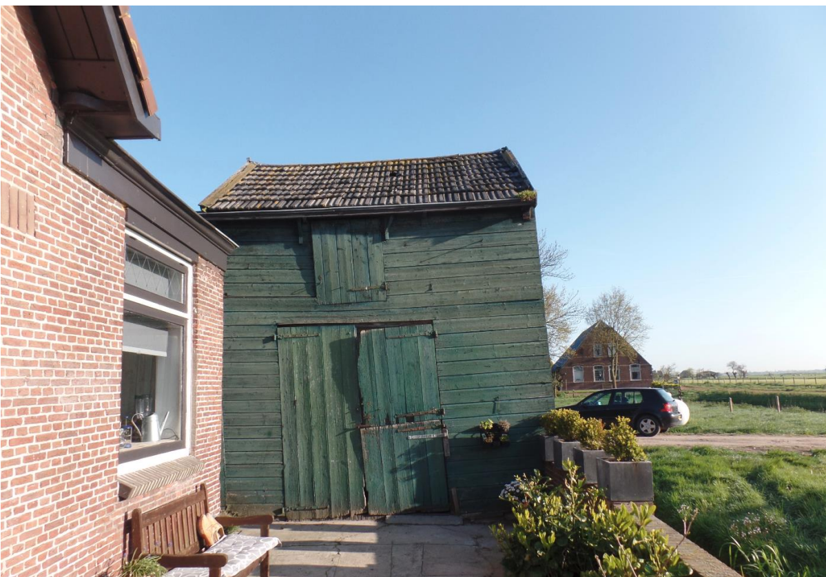
Afbeelding 10: vooraanzicht houten schuur in noordelijke richting.
