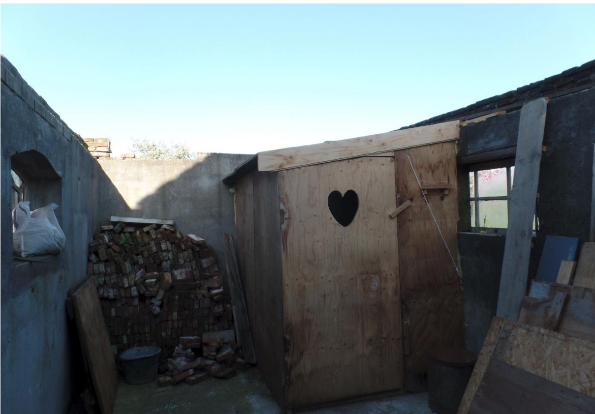
Afbeelding 8: binnenkant voormalige stenen schuur, het kippenhok heeft het aanzicht van een authentiek toilethuisje.
