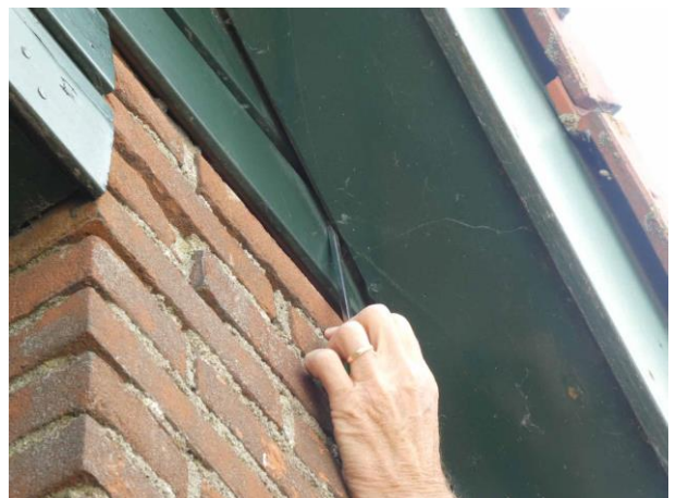
Figuur 11: foto links: geen ruimte onder dakgoot, foto rechts: geen ruimte onder overstek
