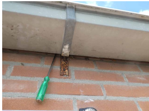
Figuur 9: foto links: golfplaten dichtgemaakt met kippengaas, foto rechts: geen ruimte onder dakgoot
