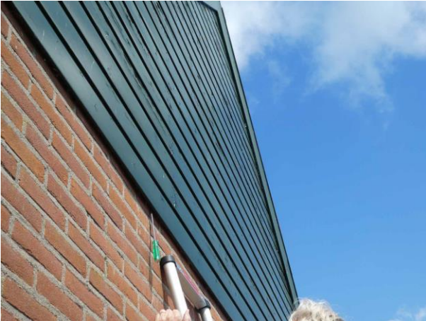
Figuur 12: foto links: geen ruimte onder en tussen rabatdelen, foto rechts: binnenzijde deel met dakpannen
