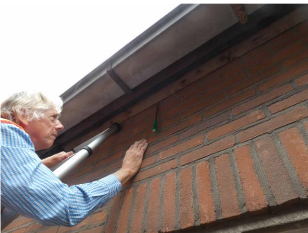
Figuur 11: foto links: geen ruimte onder dakgoot, foto rechts: geen ruimte onder overstek
