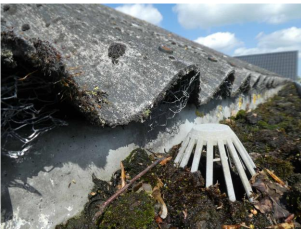
Figuur 9: foto links: golfplaten dichtgemaakt met kippengaas, foto rechts: geen ruimte onder dakgoot
