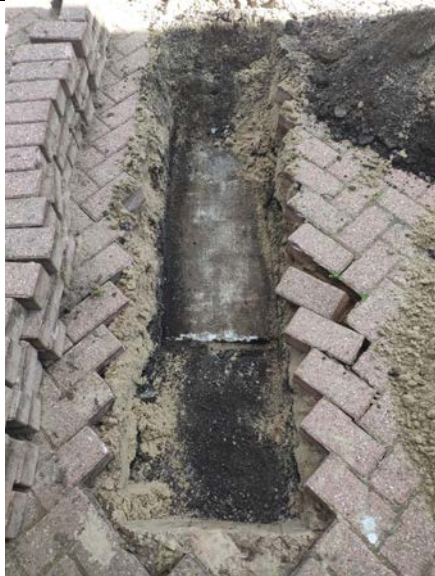
Deelplan B, inspectiesleuf SL102
