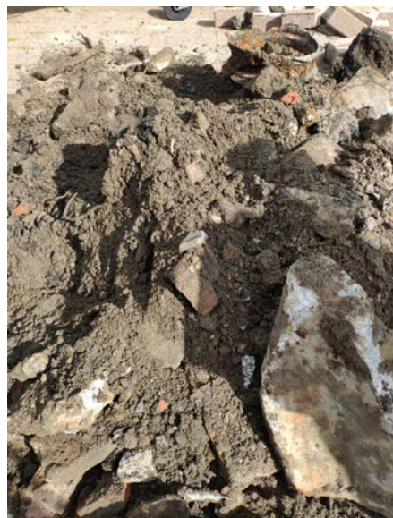
Deelplan B, inspectiesleuf SL103
