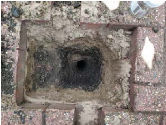
Deelplan B, inspectiegat IG109
