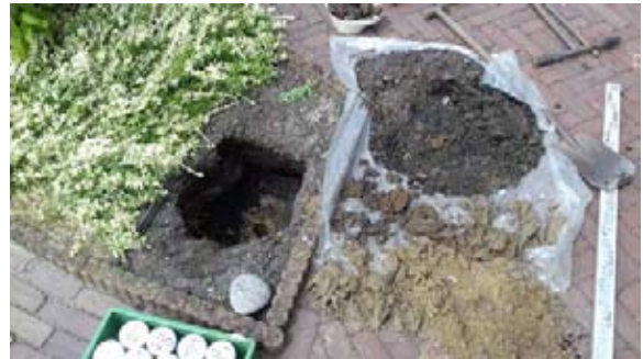
Deelplan B, inspectiegat IG108
