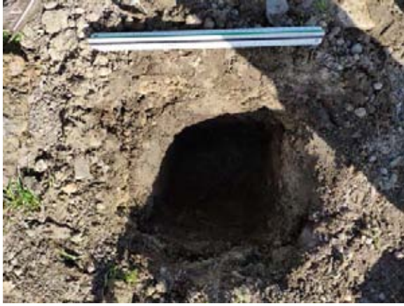
Deelplan A, inspectiegat IG09
