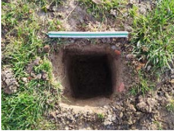
Deelplan A, inspectiegat IG01
