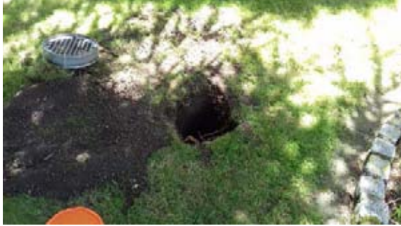
Deelplan B, inspectiegat IG111
