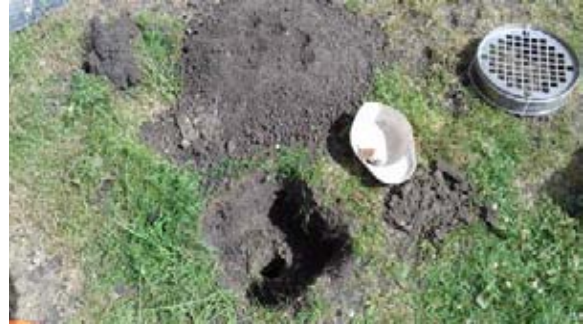
Deelplan B, inspectiegat IG106
