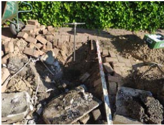
Deelplan B, inspectiesleuf SL101
