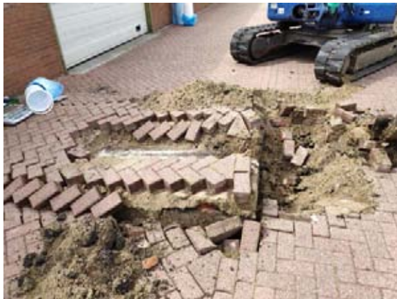
Deelplan B, inspectiesleuf SL104
