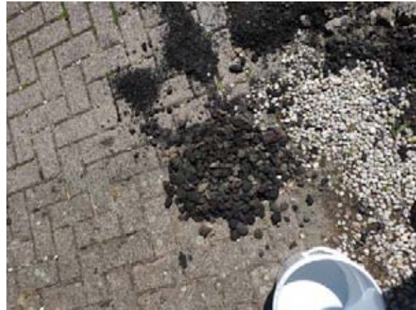
Deelplan B, inspectiesleuf SL113
