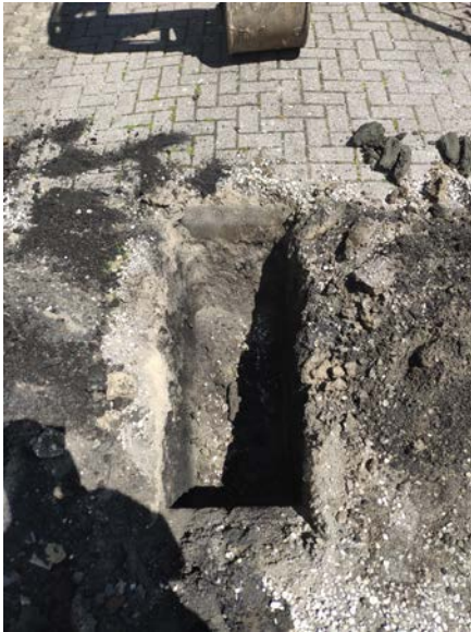
Deelplan B, inspectiesleuf SL113
