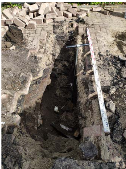
Deelplan B, inspectiesleuf SL103
