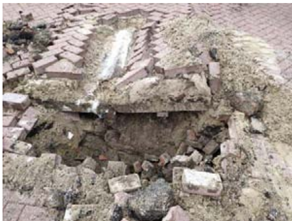
Deelplan B, inspectiesleuf SL104
