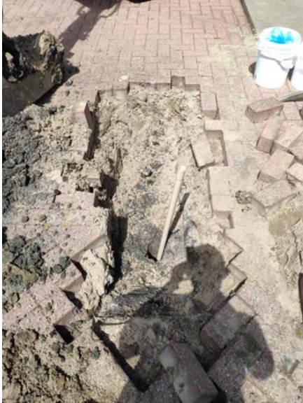
Deelplan B, inspectiesleuf SL105
