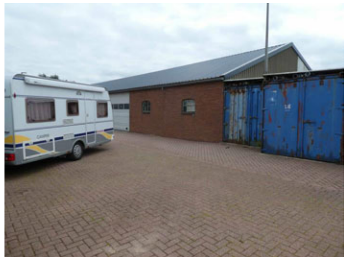
Figuur 12: Af te breken loods en zeecontainers
